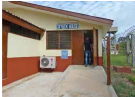
Neu errichtetes Gebäude für die Sauerstoffanlage in Akwatia
